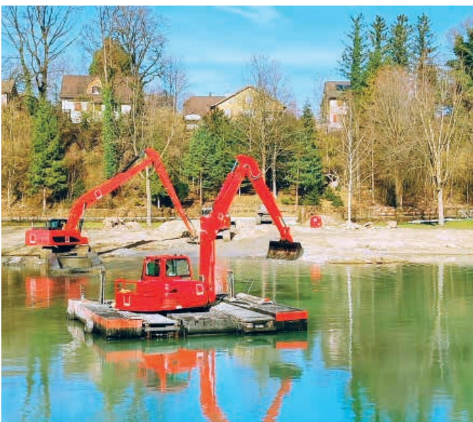
Schweizweit einziger Schwimmbagger der K. Geiges AG im Einsatz im Badiweiher Frankrichli.
