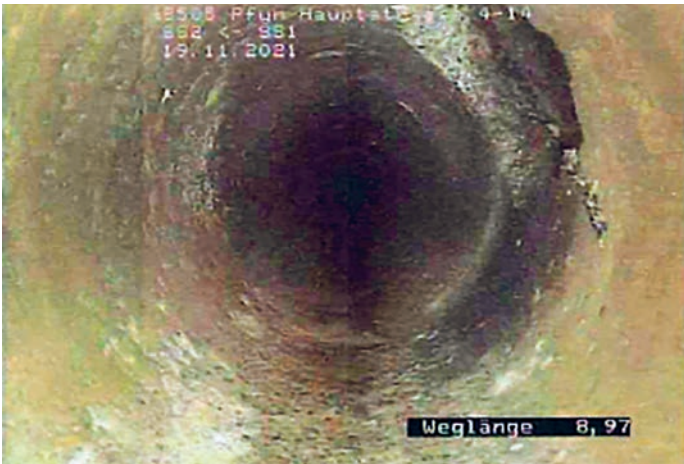
Aufnahme bei einer Kontrollfahrt im Kanal Hauptstrasse West, welche nach Abschluss der Bauarbeiten an der Wasserleitung gemacht wurde.
