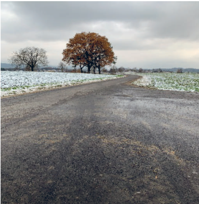
Im Strassenunterhalt haben wir 2020 einen Teil der Rütistrasse und Wybergstrasse saniert.
