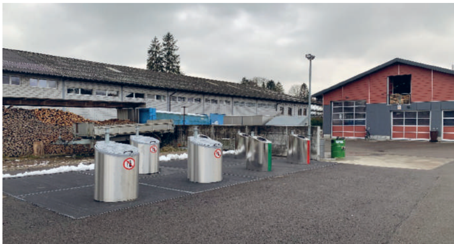
Entsorgungsstelle im Werkhof
